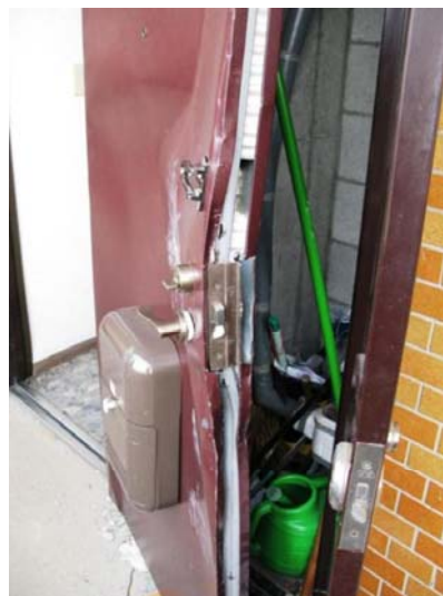
Damage of door (ドアの損傷)
